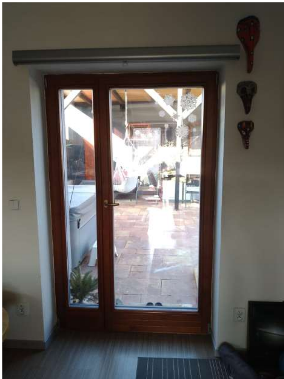
Měřicí bod – vstup (interiér)
