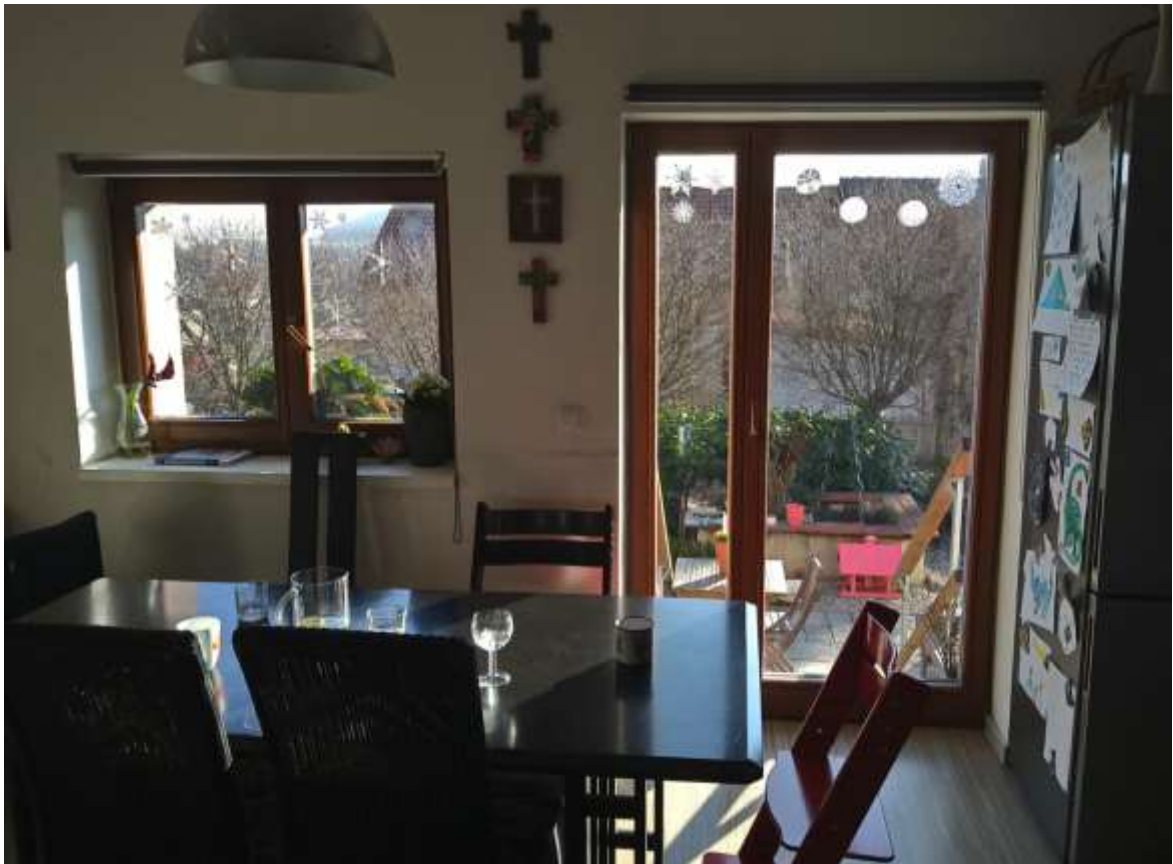
Měřící bod – francouzské okno (vstup na zahradu - interiér)
