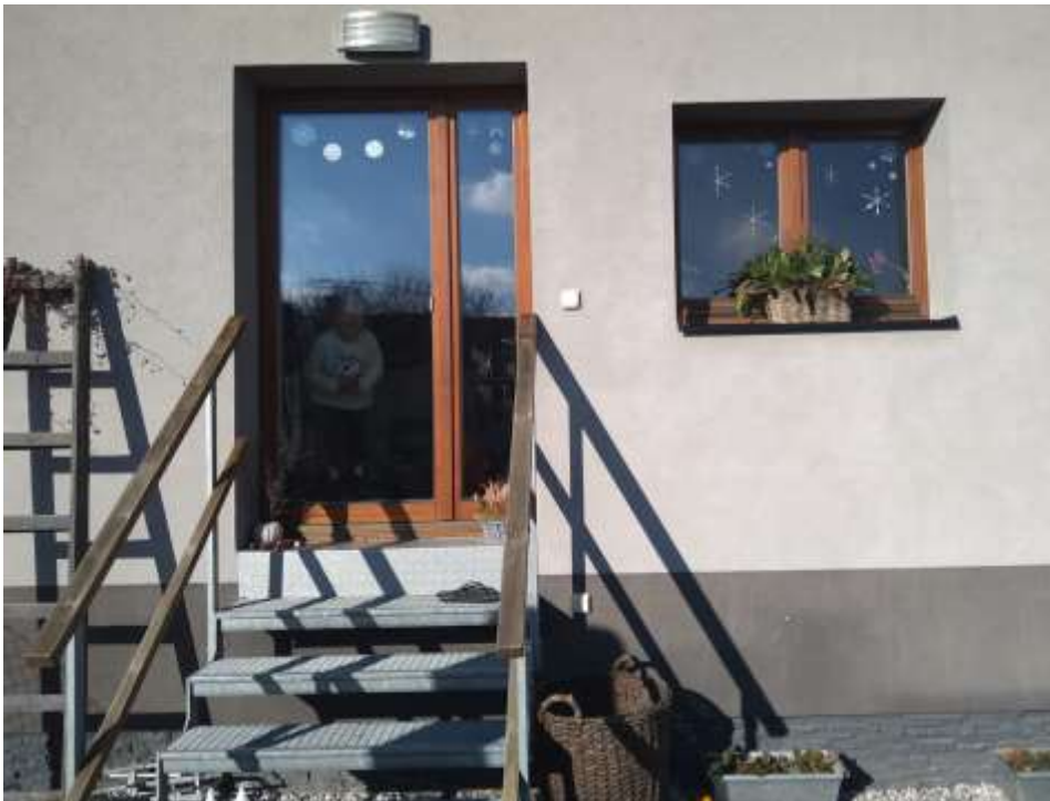
Měřící bod – francouzské okno (vstup na zahradu - exteriér)
