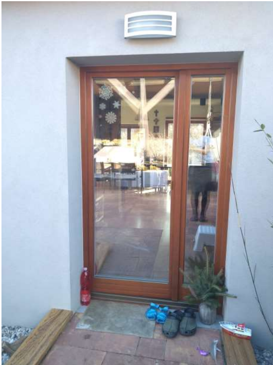
Měřící bod – vchod (exteriér)
